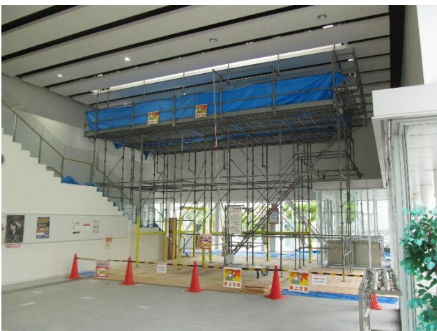
施工中の様子
